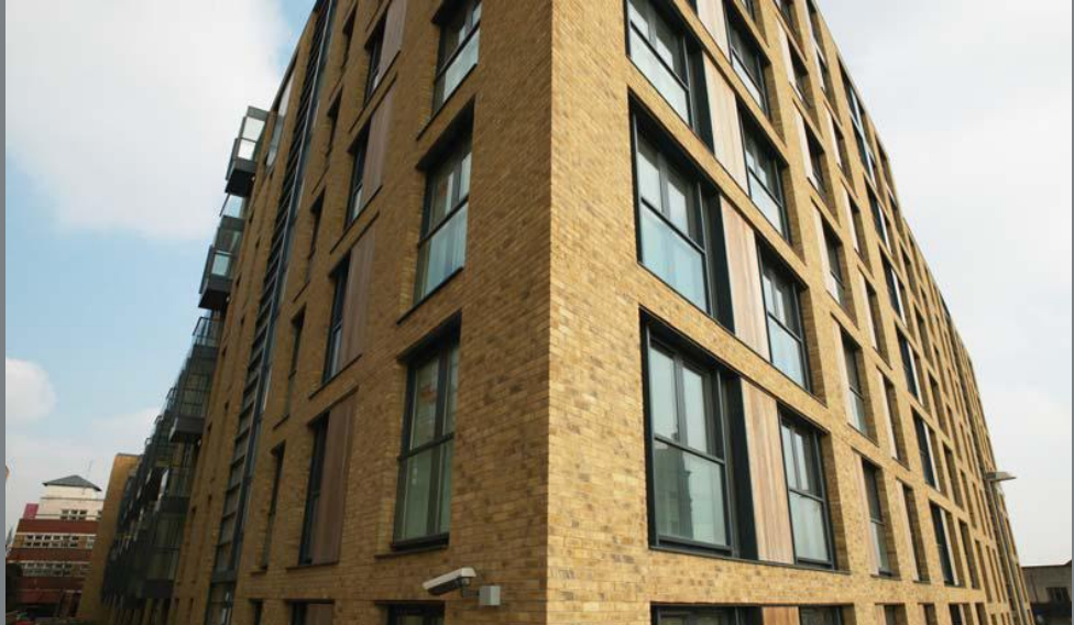
B5 Southside, Birmingham 2 extractores, 13 Cyclones, 2 ventiladores de toma de aire, Sumideros y parrillas, CO y detectores de humo.
