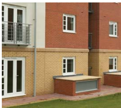
Lamas de ventilación en los apartamentos Observatory, Walsall
